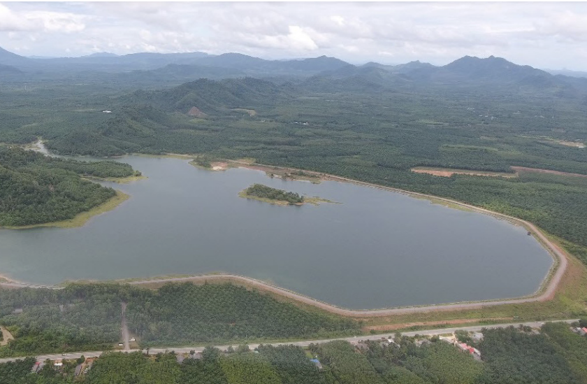
• อ่างเก็บน้ำห้วยน้ำเขียวอันเนื่องมาจากพระราชดำริ
