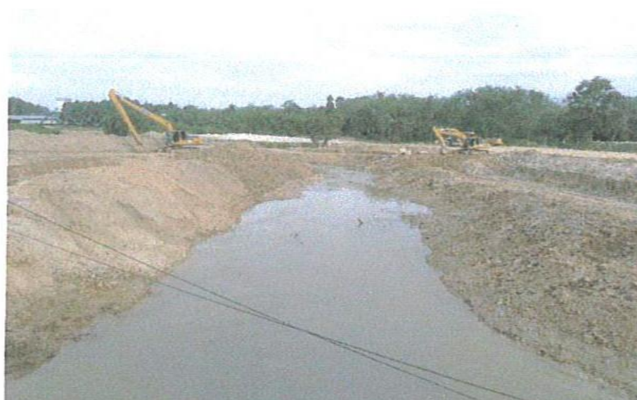
รูปที่ 17 งานทางผันน้ำชั่วคราว
