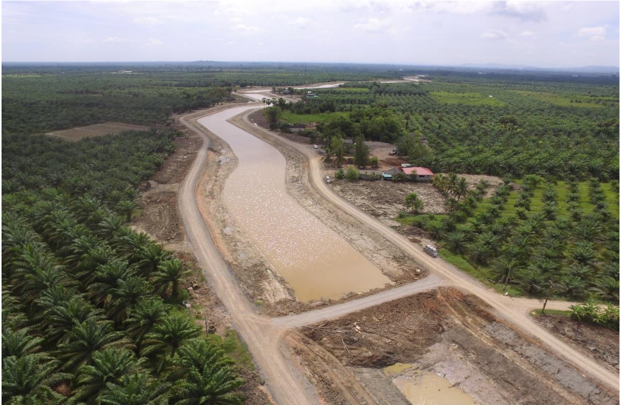
รูปที่ 10 ทำนบกั้นดิน และงานสูบน้ำระหว่างก่อสร้าง
