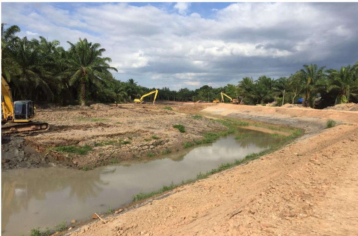
รูปที่ 8 ทำนบกั้นดิน และงานสูบน้ำระหว่างก่อสร้าง
