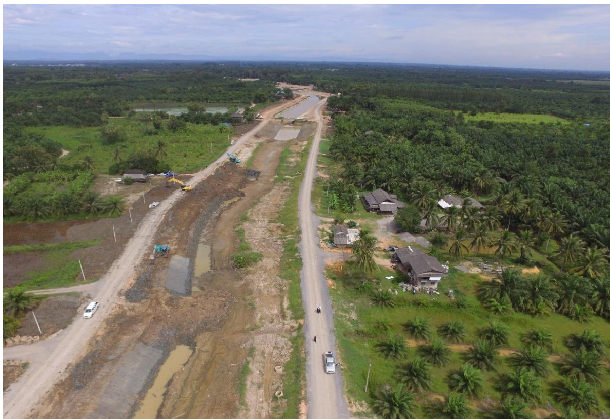
รูปที่ 9 ทำนบกั้นดิน และงานสูบน้ำระหว่างก่อสร้าง
