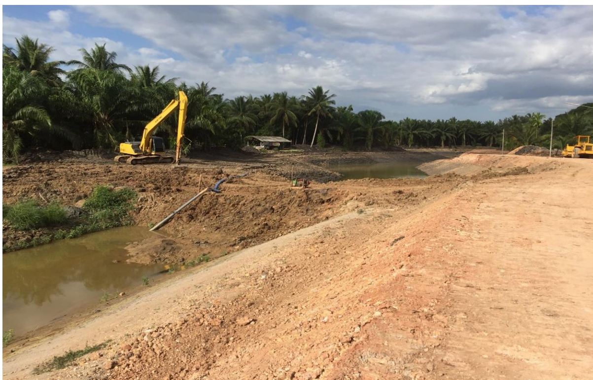
รูปที่ 7 ทำนบดิน และงานสูบน้ำระหว่างก่อสร้าง
