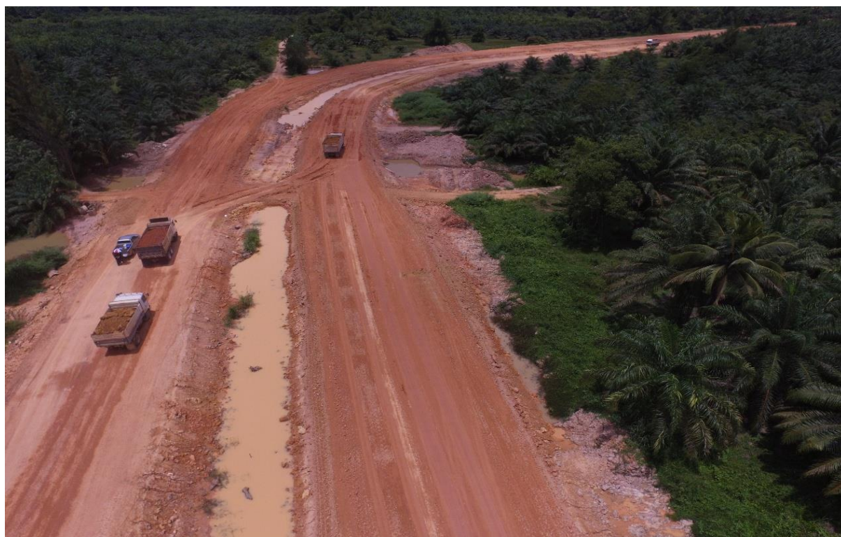
รูปที่ 5 การบดอัดดิน งานดินถมบดอัดแน่นด้วยเครื่องจักร
