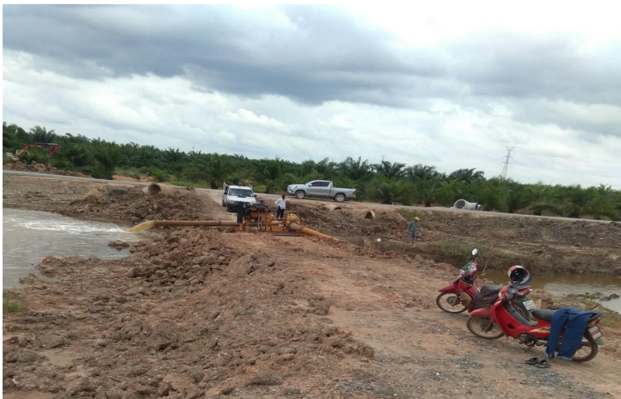
รูปที่ 6 ทำนบดิน และงานสูบน้ำระหว่างก่อสร้าง
