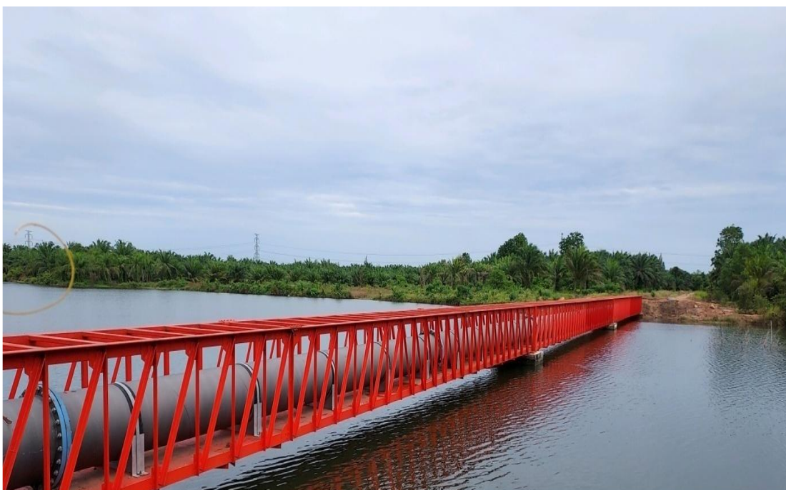
รูปที่ 15 รูปแสดงงานก่อสร้างท่อส่งน้ำ 3L-MC1
