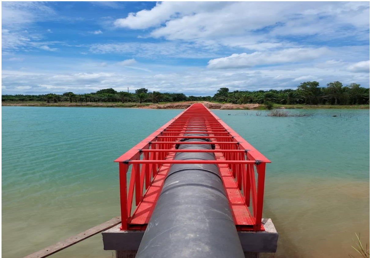
รูปที่ 14 รูปแสดงงานก่อสร้างท่อส่งน้ำ 3L-MC1
