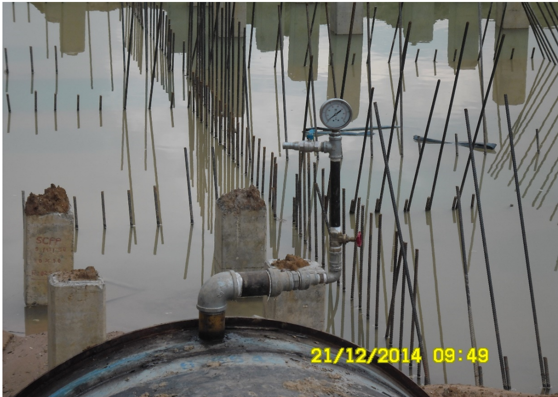
รูปที่ 8 งานติดตั้งเครื่องสูบน้ำขนาดใหญ่ โครงการพัฒนาลุ่มน้ำตาปี-พุมดวง จังหวัดสุราษฎร์ธานี
