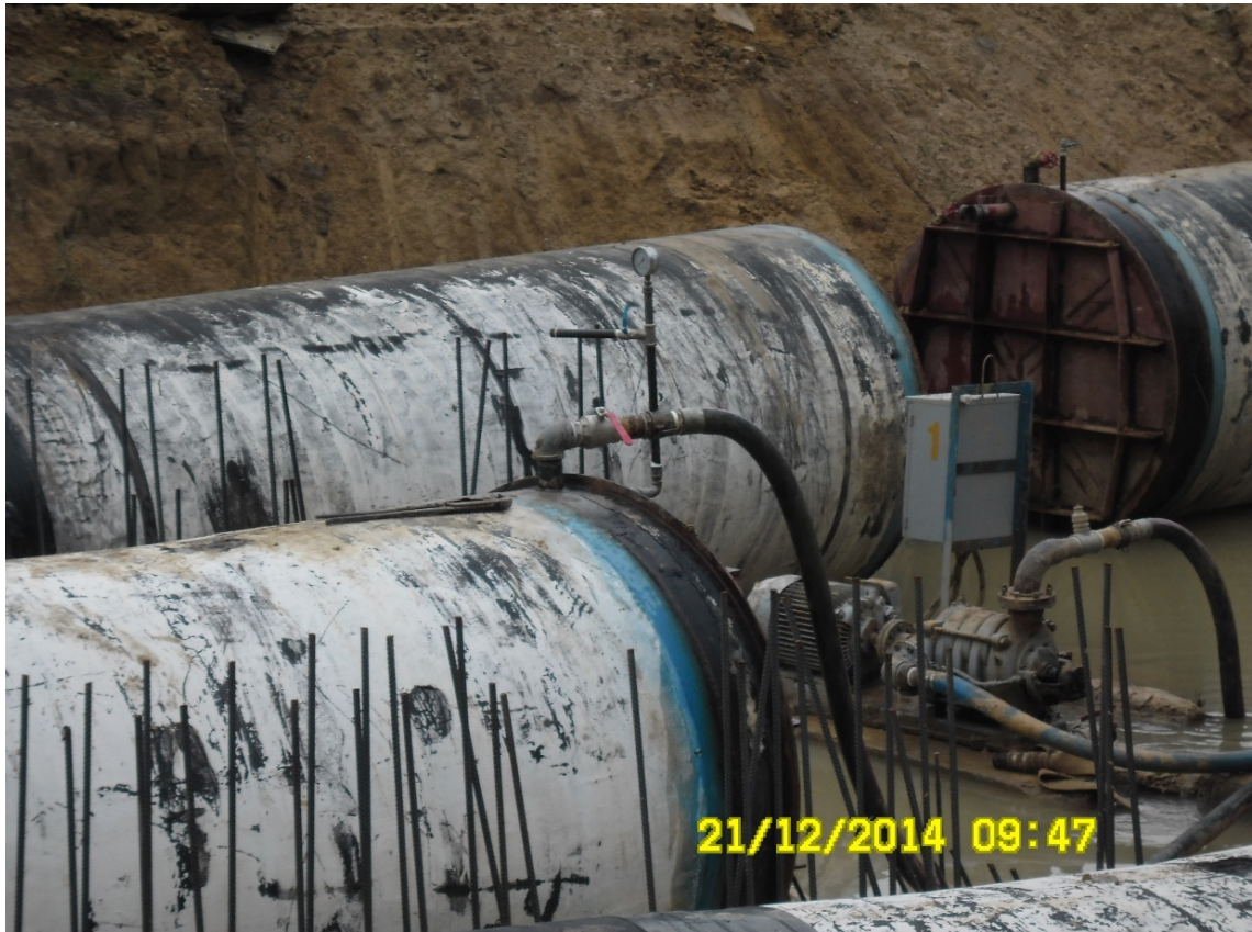
รูปที่ 9 งานติดตั้งเครื่องสูบน้ำขนาดใหญ่ โครงการพัฒนาลุ่มน้ำตาปี-พุมดวง
