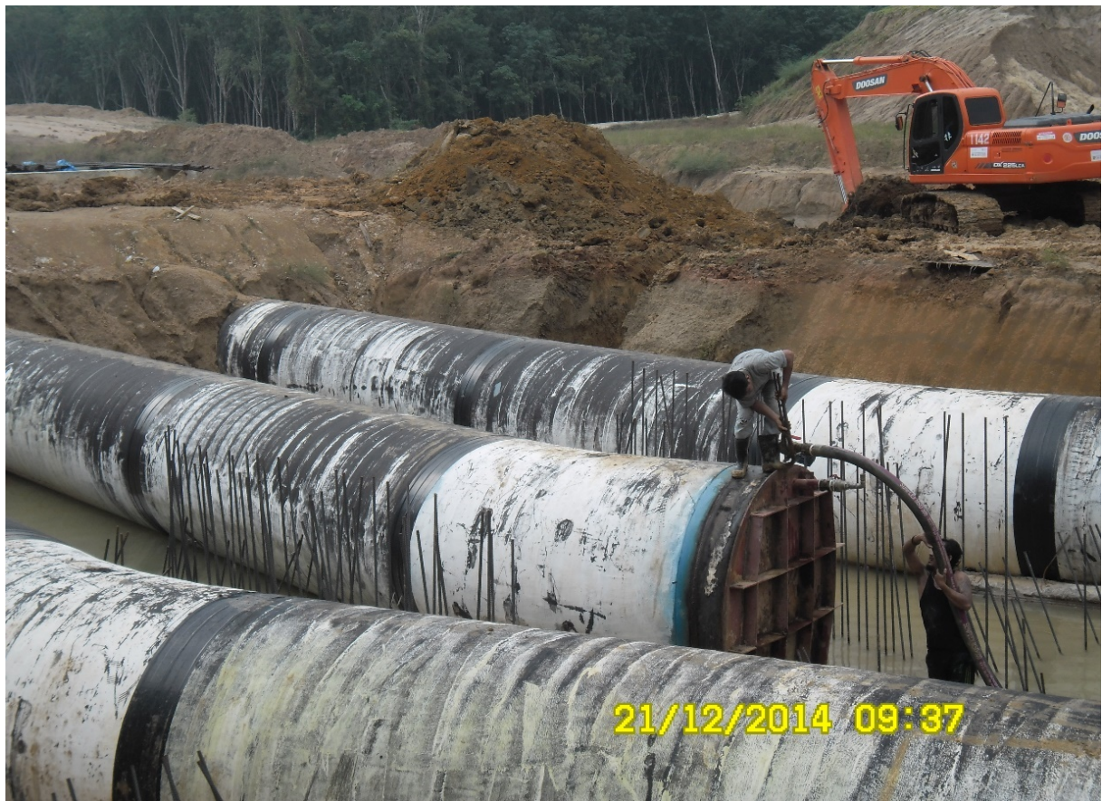
รูปที่ 7 งานติดตั้งเครื่องสูบน้ำขนาดใหญ่ โครงการพัฒนาลุ่มน้ำตาปี-พุมดวง จังหวัดสุราษฎร์ธานี
