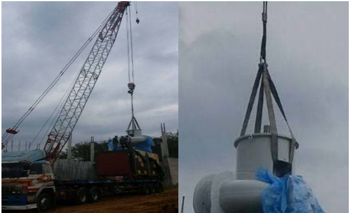
รูปที่ 5 งานติดตั้งเครื่องสูบน้ำขนาดใหญ่ โครงการพัฒนาลุ่มน้ำตาปี-พุมดวง จังหวัดสุราษฎร์ธานี
