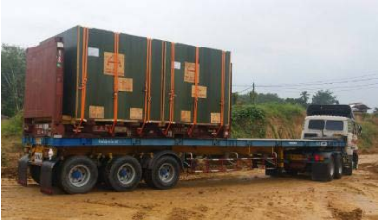
รูปที่ 4 งานติดตั้งเครื่องสูบน้ำขนาดใหญ่ โครงการพัฒนาลุ่มน้ำตาปี-พุมดวง จังหวัดสุราษฎร์ธานี
