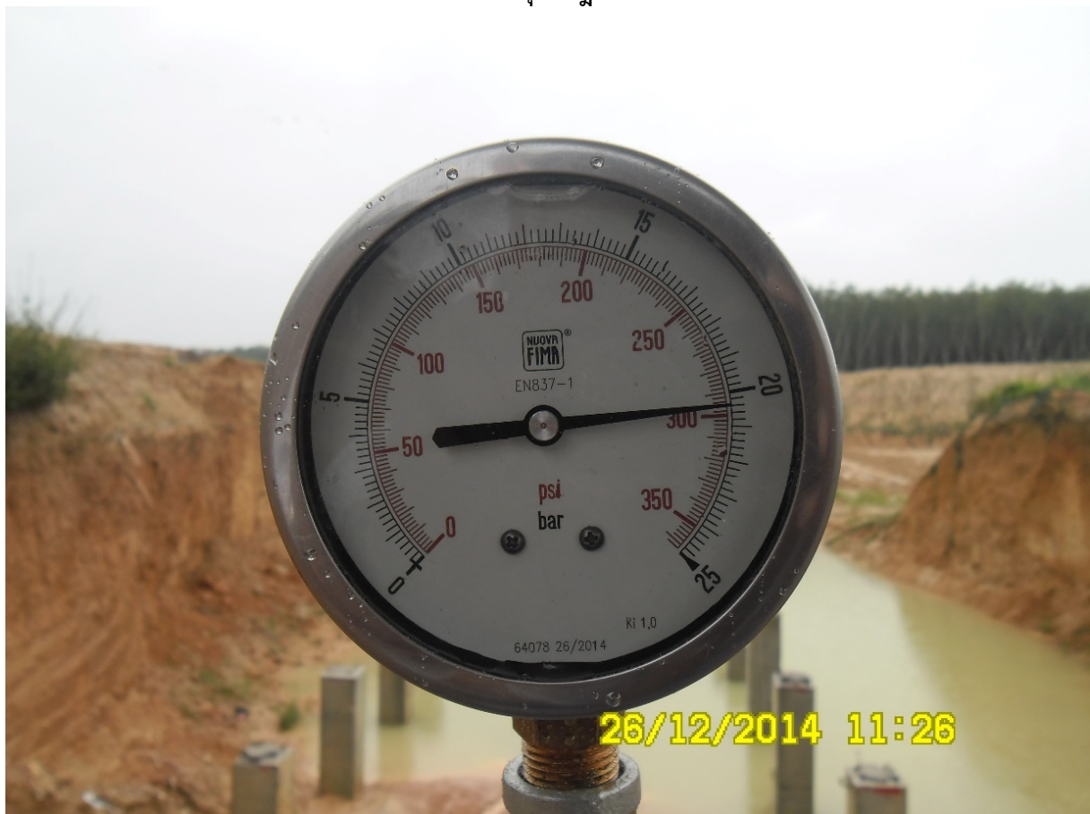
รูปที่ 10 งานติดตั้งเครื่องสูบน้ำขนาดใหญ่ โครงการพัฒนาลุ่มน้ำตาปี-พุมดวง จังหวัดสุราษฎร์ธานี
