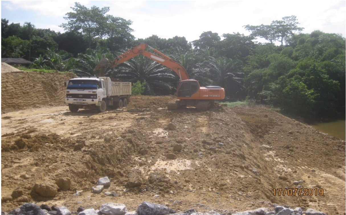
รูปที่ 11 การแก้ไขปัญหาการกัดเซาะของลำน้ำ บริเวณห้วงงานสถานีสูบน้ำ
