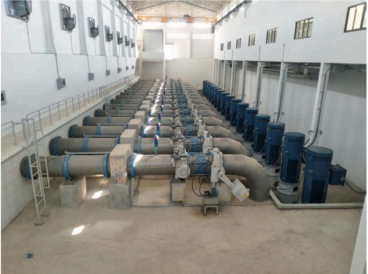
รูปที่ 6 งานติดตั้งเครื่องสูบน้ำขนาดใหญ่ โครงการพัฒนาลุ่มน้ำตาปี-พุมดวง จังหวัดสุราษฎร์ธานี
