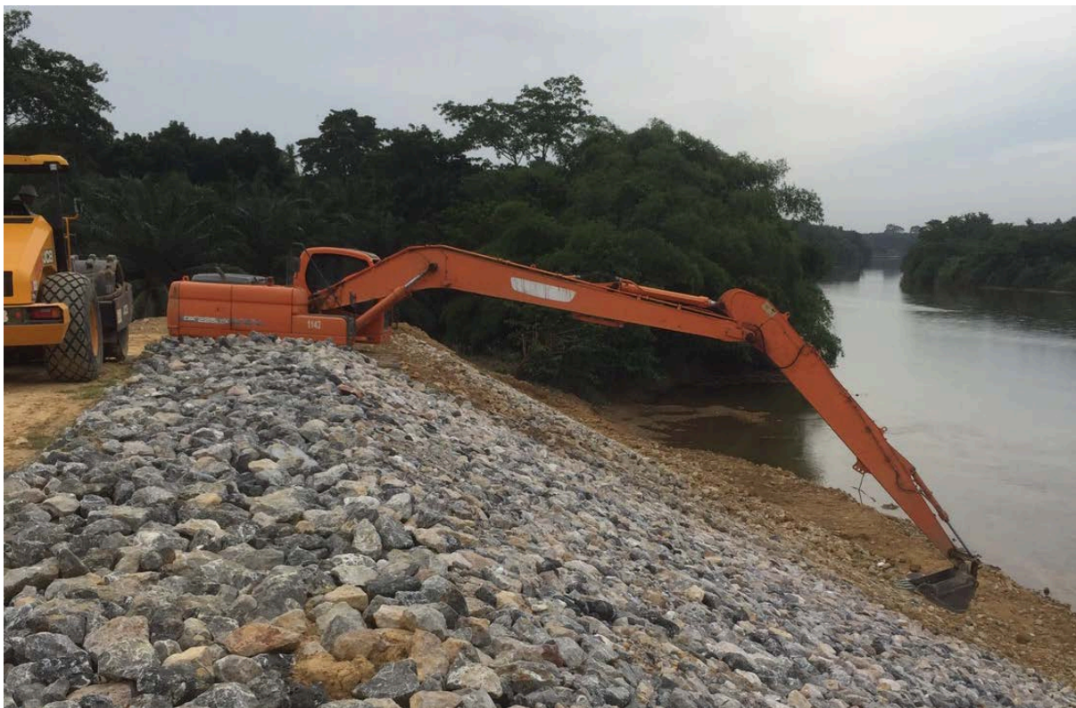
รูปที่ 12 การแก้ไขปัญหาการกัดเซาะของลำน้ำ บริเวณห้วงงานสถานีสูบน้ำ
